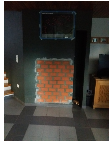
Verbouwingswerken Van Der Veken
