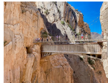
Brug in Caminito del rey
